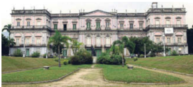
Das Nationalmuseum vor dem Brand, der viele wertvolle Stücke und Sammlungen zerstörte. Eine bessere Instandhaltung hätte das verhindern können
