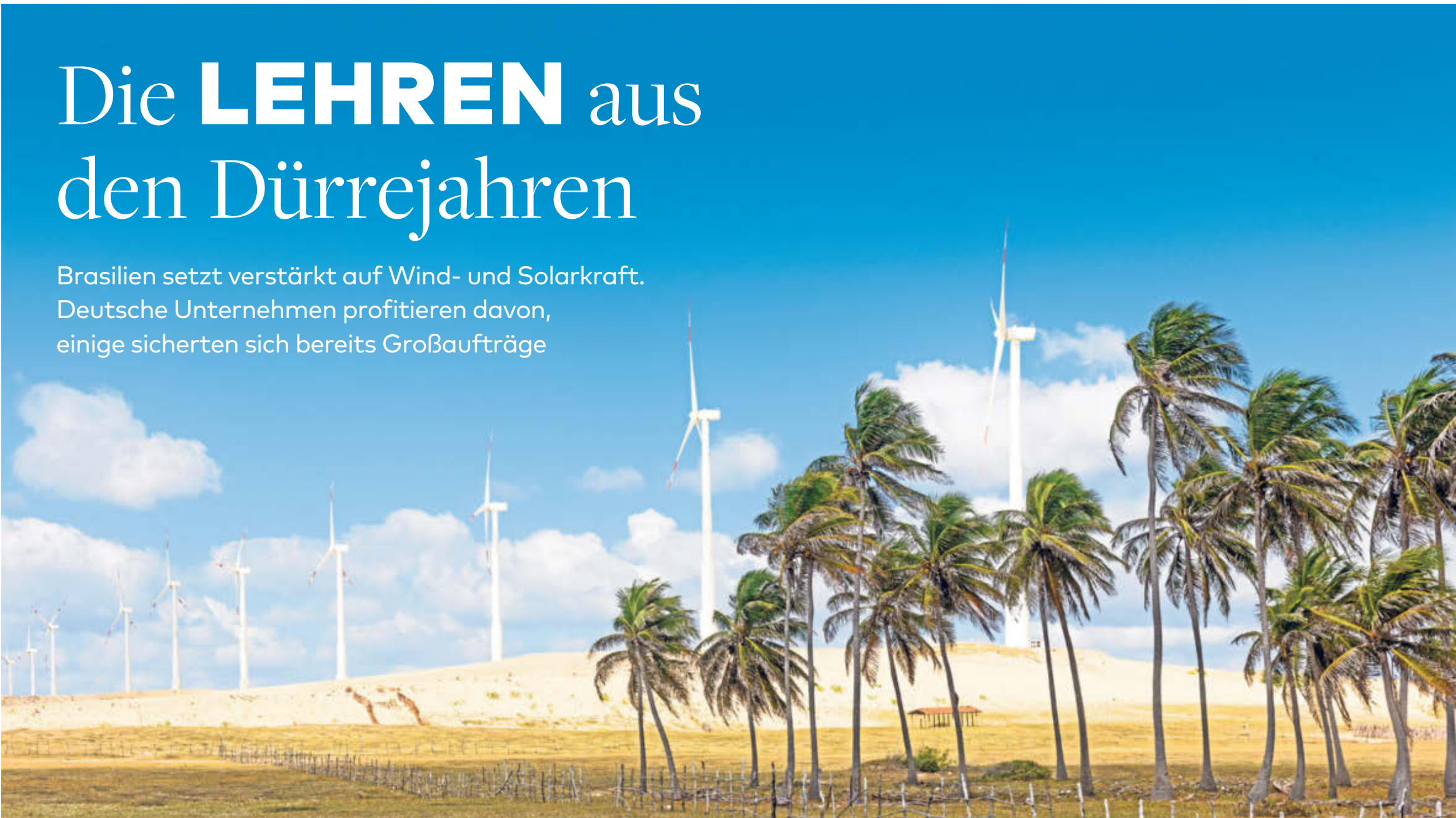
Eine Windfarm in Taiba im nördlichen Bundesstaat Ceará. Mit einer installierten Stromerzeugungskapazität von gut 13,2 Gigawatt ist Brasilien heute bereits der achtgrößte Produzent von Windenergie
