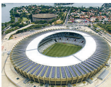
Das Stadion in Belo Horizonte mit der imposanten Photovoltaik-Anlage
